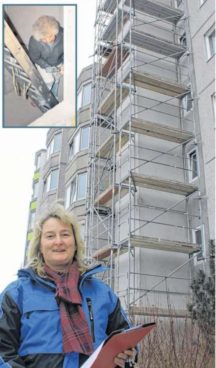
Neuwoges-Bauleiterin Susan Barda betreut die Fahrstuhl-Nachrüstung in der Milarch-Straße, mit der Arno Star (kleines Foto) derzeit beschäftigt ist.
