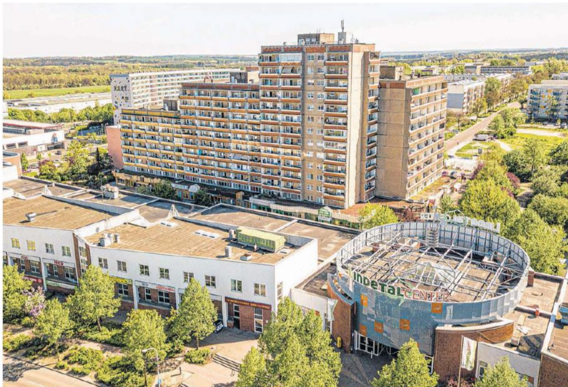
Das Stufenhochhaus im Juri-Gagarin-Ring in der Neubrandenburger Oststadt will die NeuwoGes instand setzen. In einem ersten Abschnitt werden in diesem Jahr 5,4 Millionen Euro investiert.
