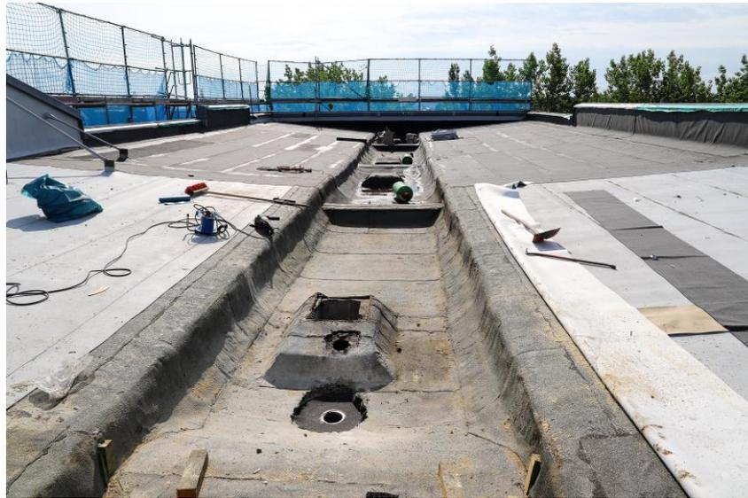
Neue Dachventilatoren und bestehende Aufbauten werden im Zuge der Baumaßnahme fachgerecht abgedichtet, um das Eindringen von Wasser zu verhindern. Zur Sicherung der Dachfläche werden sogenannte Sekuranten montiert, um zukünftige Wartungsarbeiten und Inspektionen sicherer zu machen. Das Ergebnis ist ein langfristig geschütztes, wetterbeständiges und funktionales Dach.
