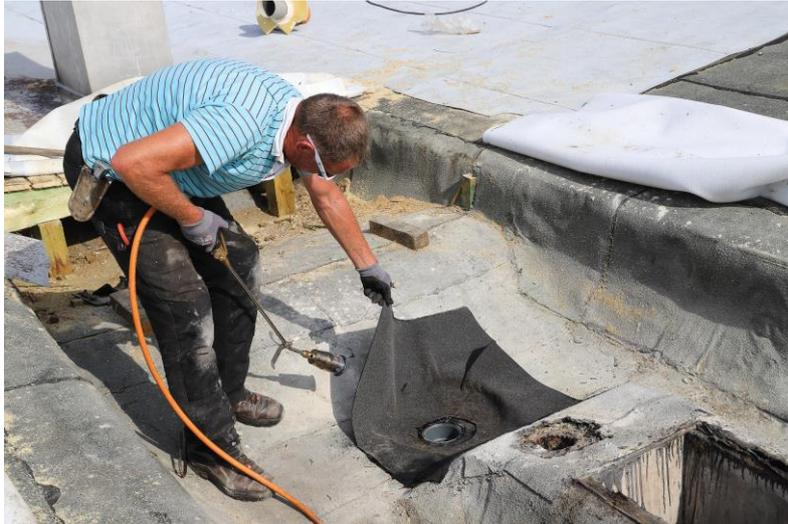
Das Dach, das vor fast 30 Jahren das letzte Mal modernisiert wurde, wird erneuert. Ausgetauscht werden die Dachabdichtung und die Dachrandprofile, genau wie die Regenwassereinläufe. An der Traufkante zwischen den Balkonen und auf den Balkonvordächern wird zudem eine Taubenabwehr installiert, um Verschmutzungen und Beschädigungen durch die Tiere zu verhindern.
