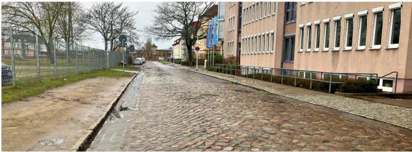
In der Neubrandenburger Heidenstraße soll die Instandsetzung am 10. Februar beginnen.
